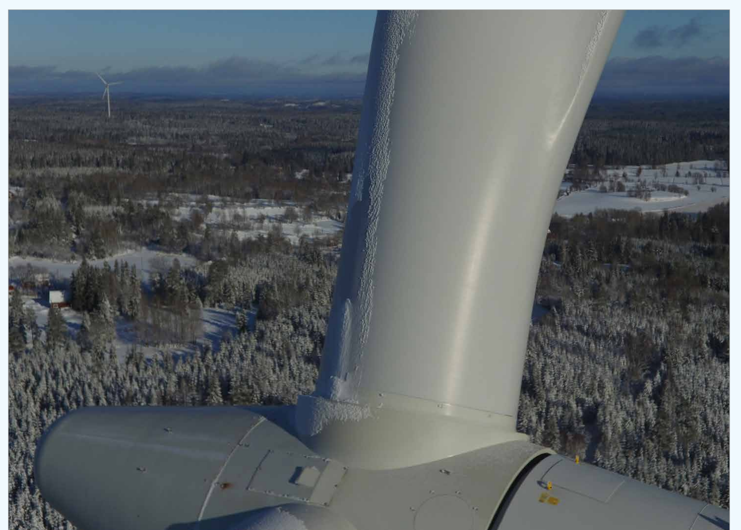
Isbildning på vindkraftverk
