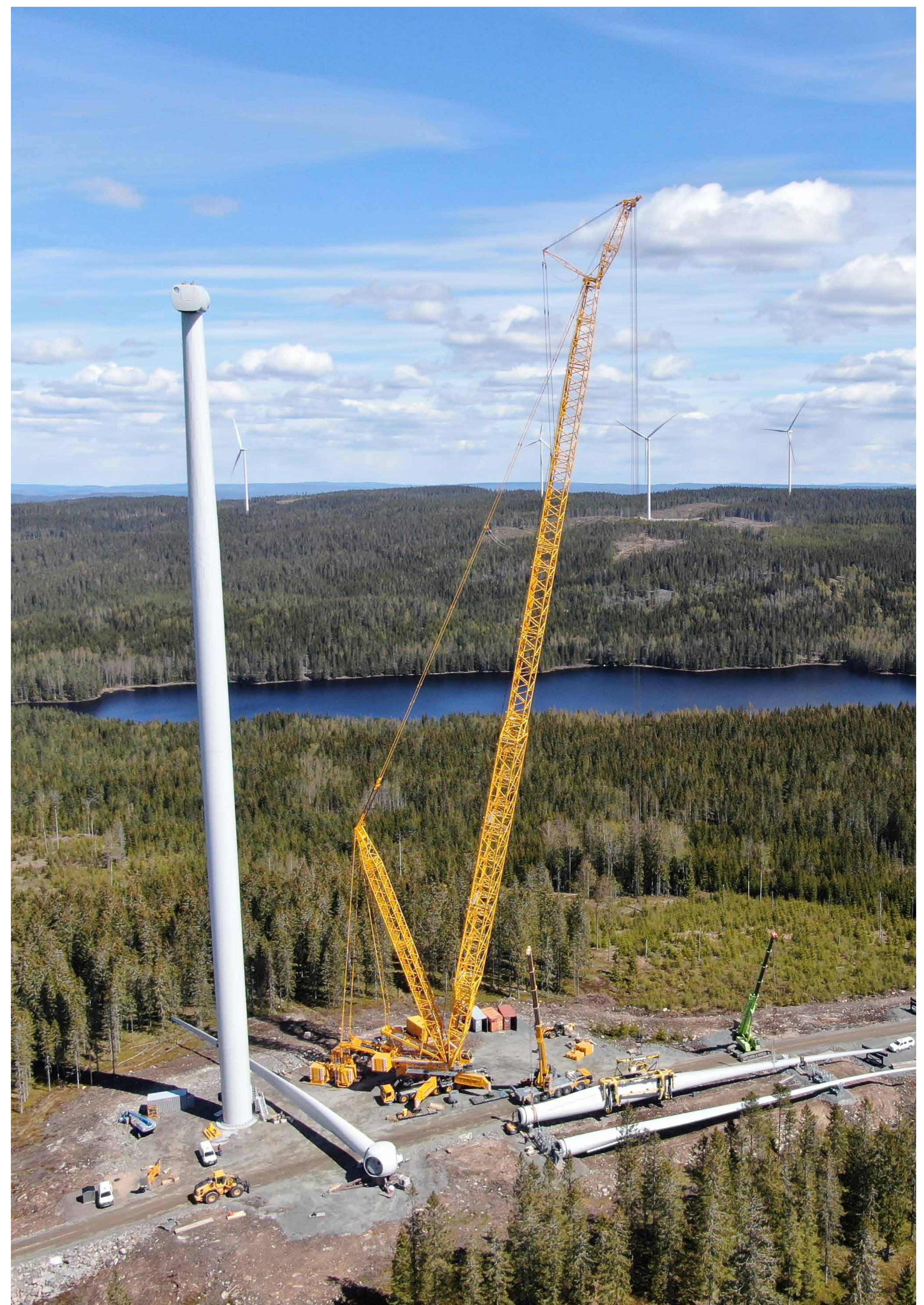
Montering av vindkraftverkets blad
