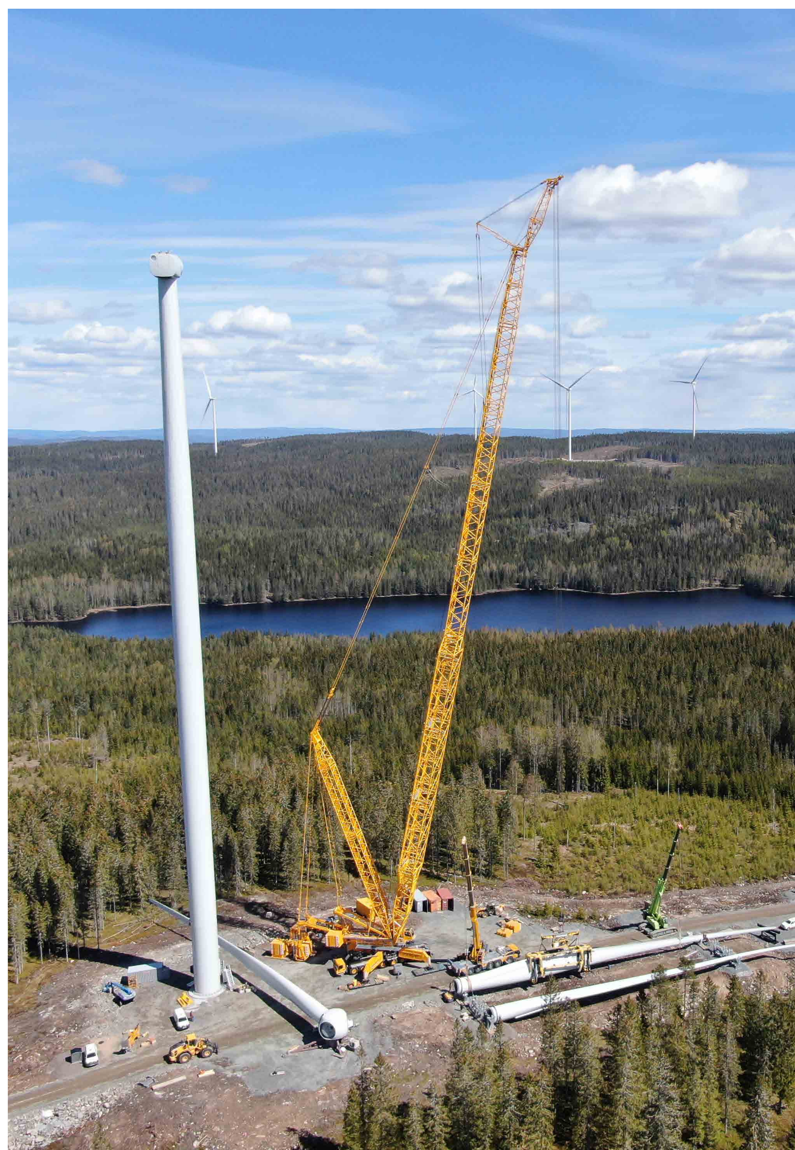
Montering av vindkraftverkets blad
