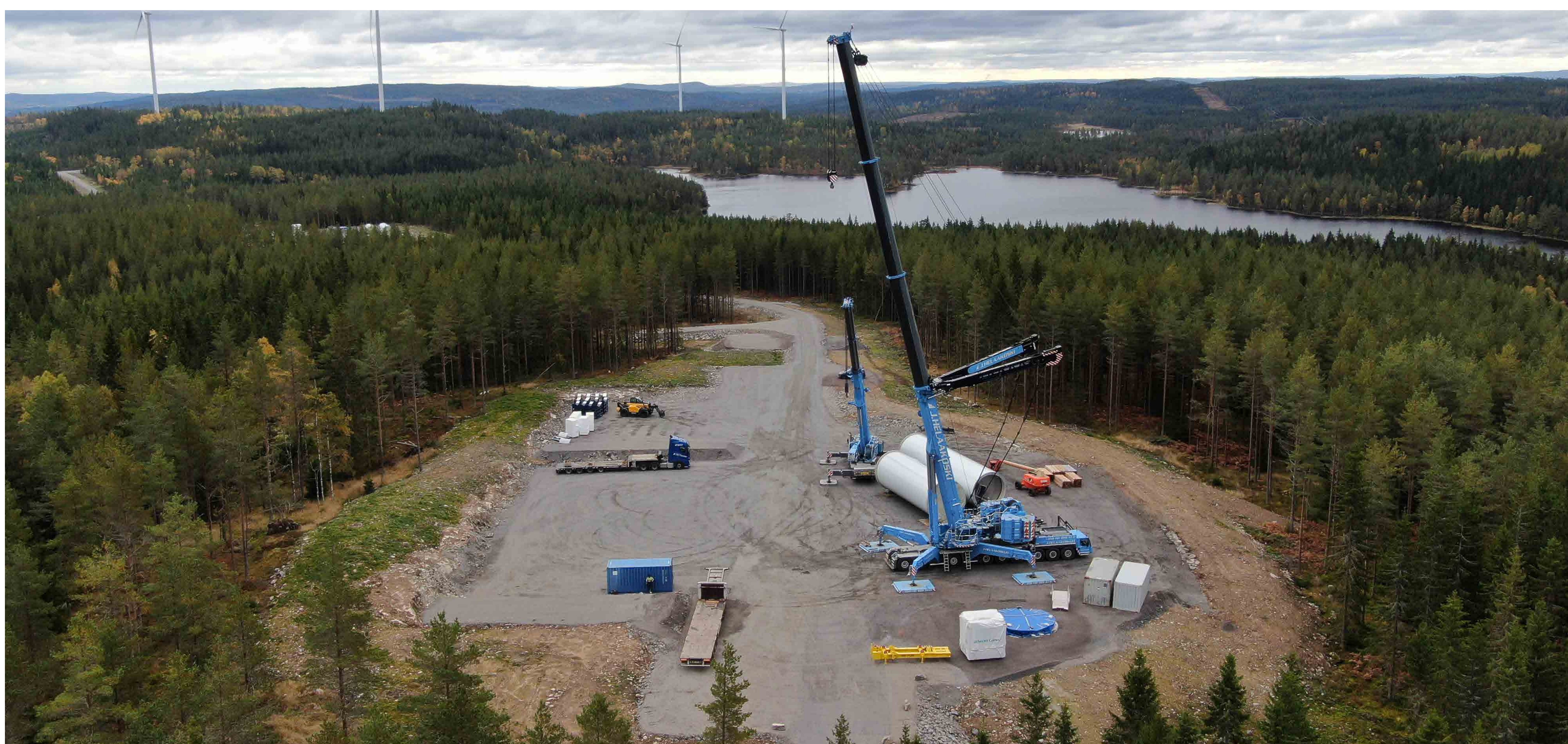
Arbets- och upplagsytor vid ett vindkraftverk
