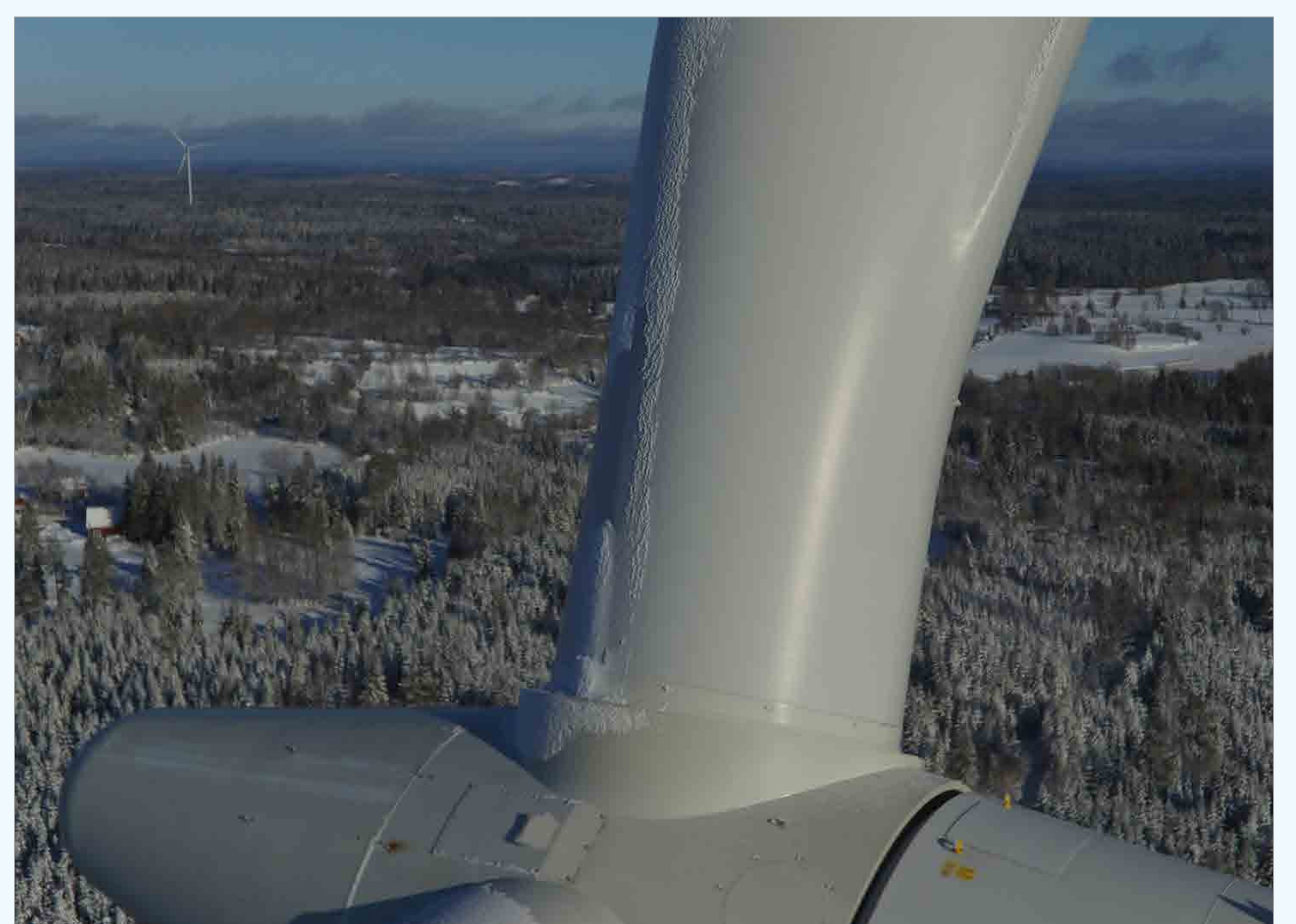
Isbildning på vindkraftverk
