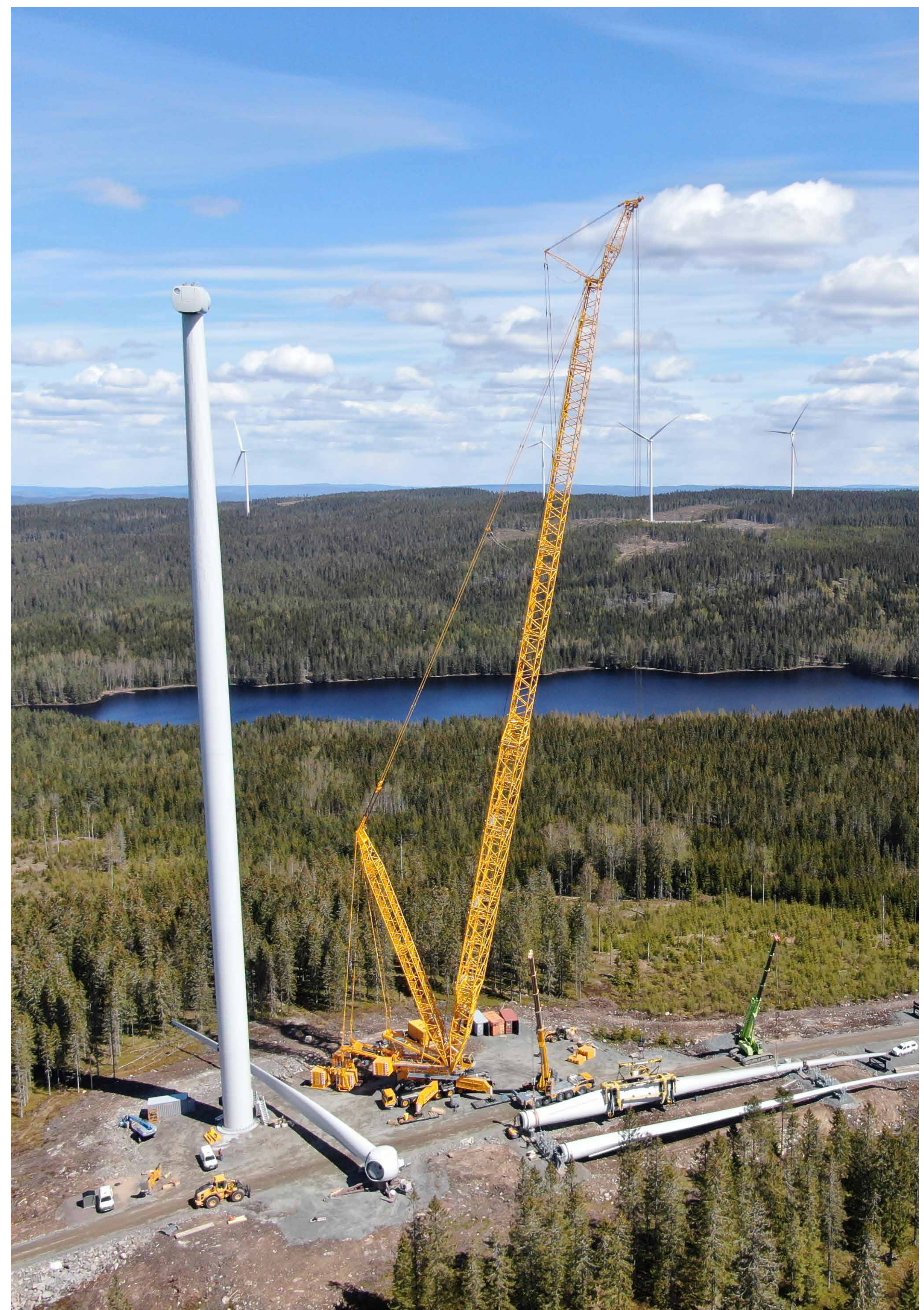
Montering av vindkraftverkets blad
