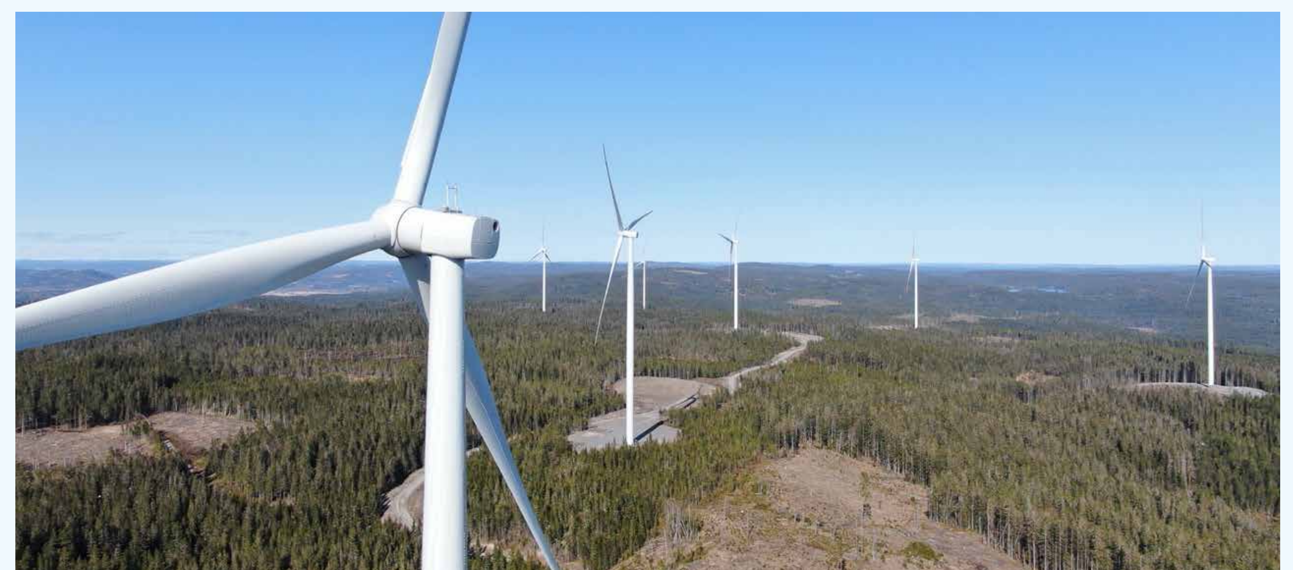
För vindkraftsparken Häjsberget och södra Länsmansberget i Värmland har Tekniska verken gett bygdepeng till bland annat renovering av en hembygdsgränd, handikappanpassning av en fiskebrygga och byggande av vindskydd för allmänheten.
