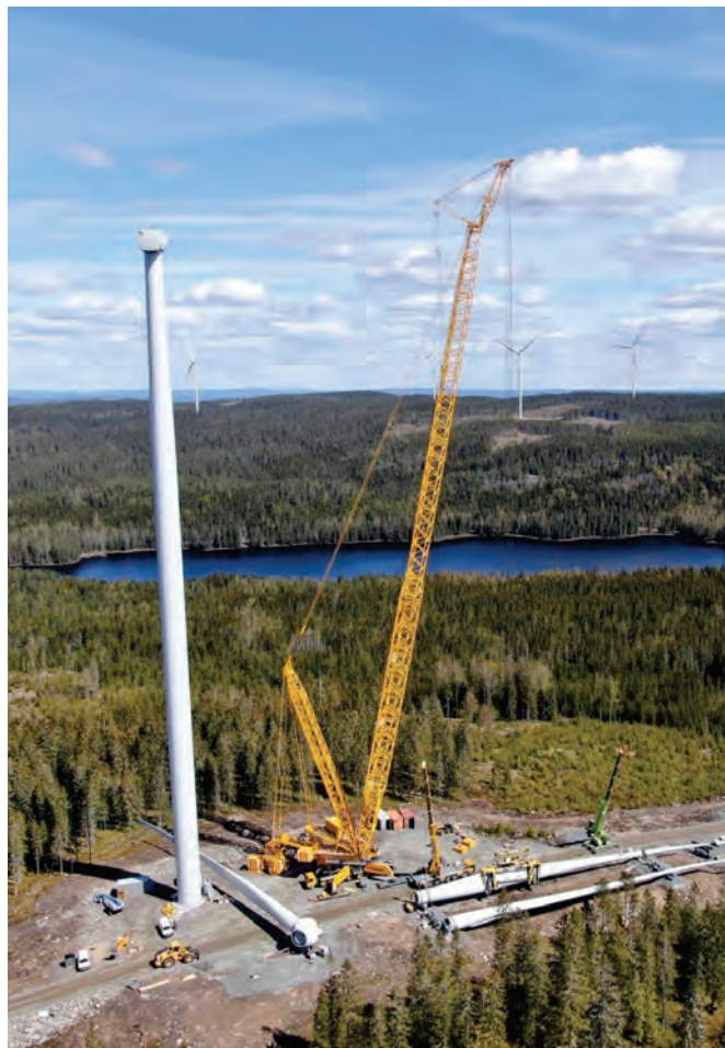
Montering av vindkraftverkets blad
