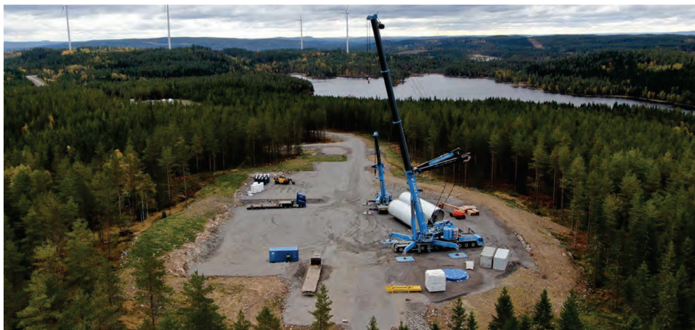
Arbets- och upplagsytor vid ett vindkraftverk
