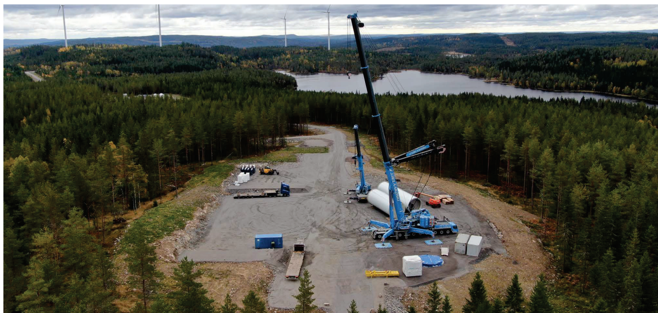
Arbets- och upplagsytor vid ett vindkraftverk
