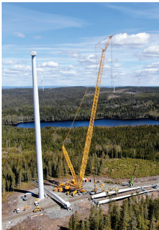
Montering av vindkraftverkets blad
