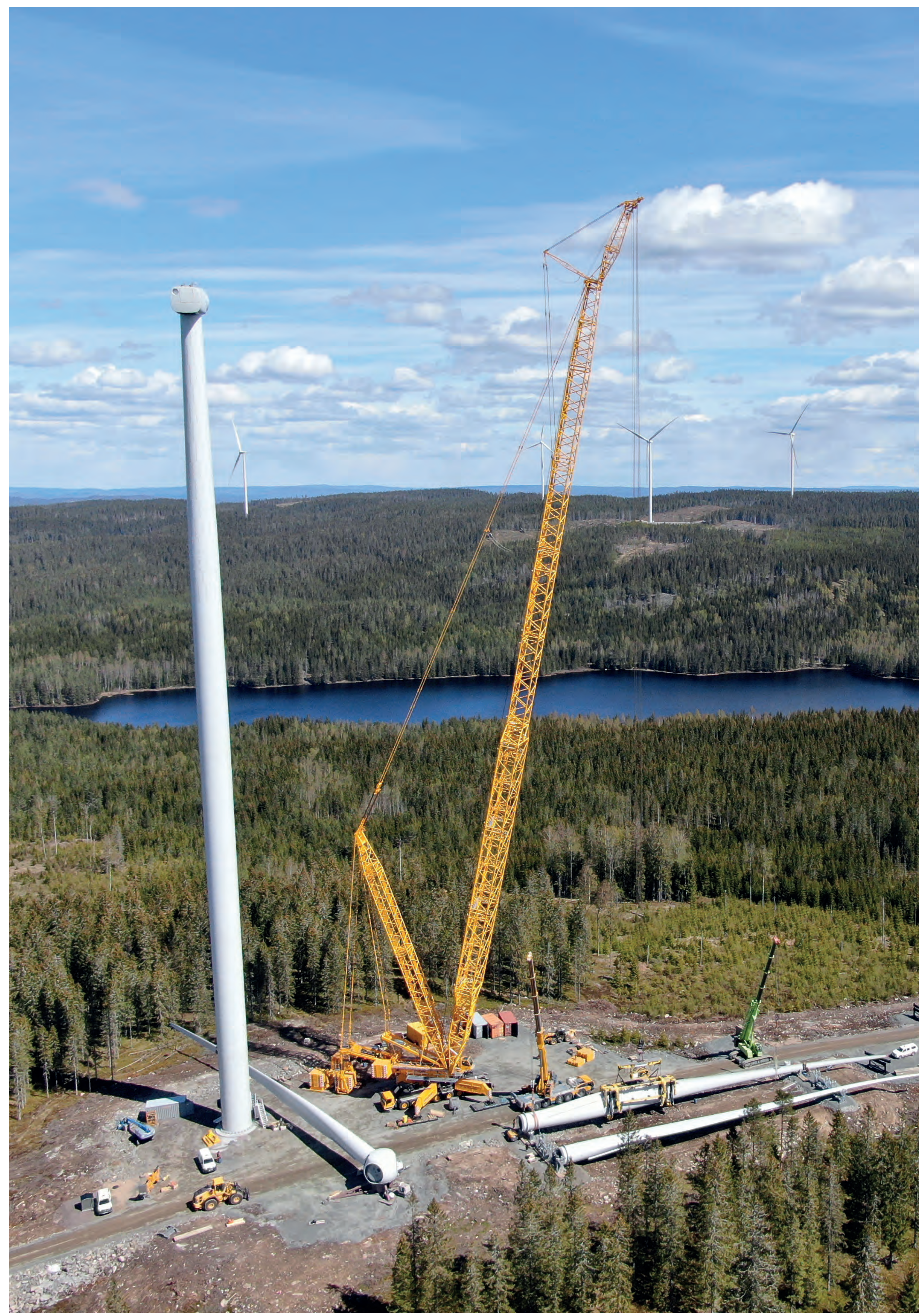
Montering av vindkraftverkets blad
