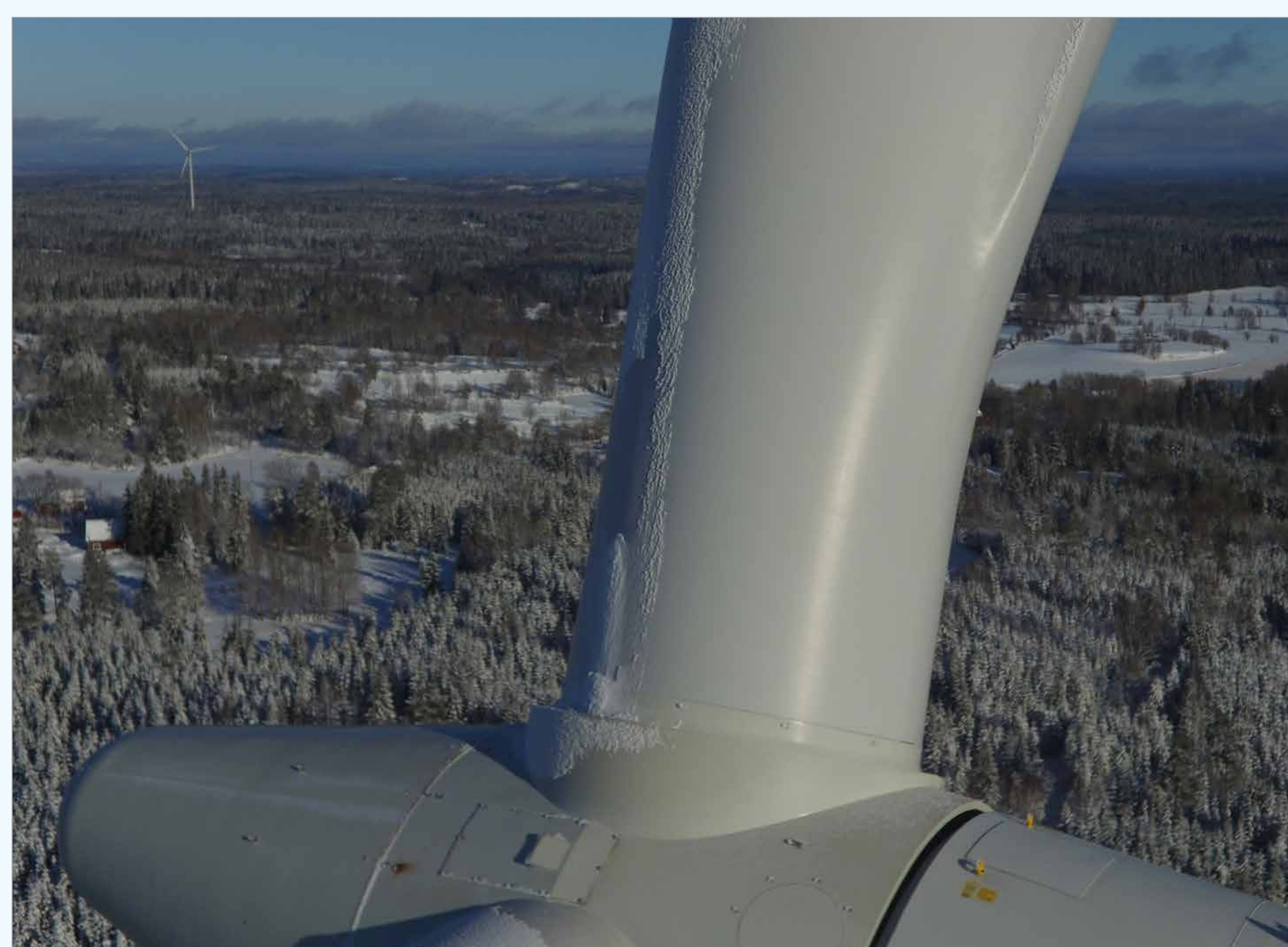
Isbildning på vindkraftverk
