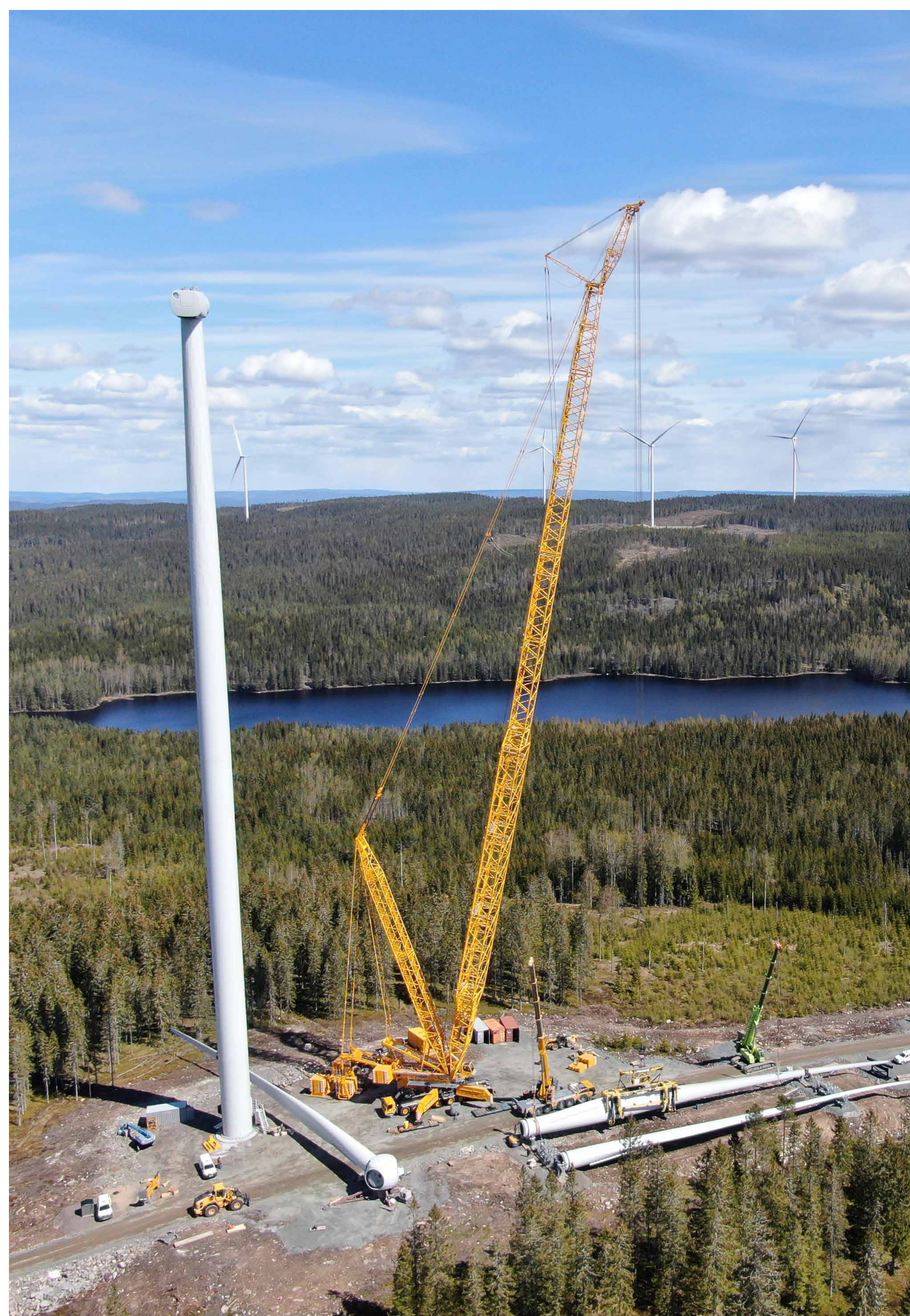
Montering av vindkraftverkets blad
