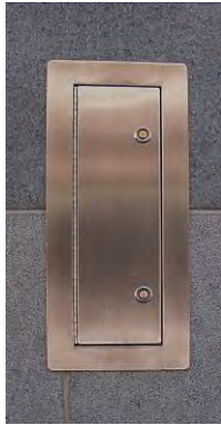
Infälld säkringscentral med rostfri front
